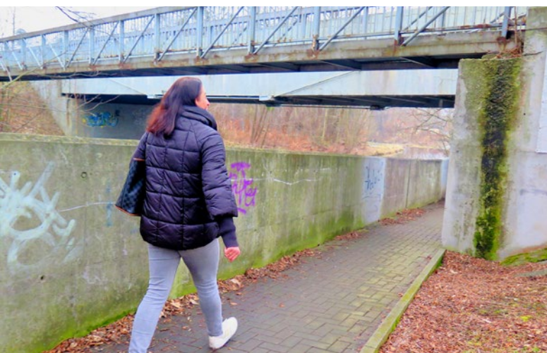
[ 9 ] Przejście pod drogą
