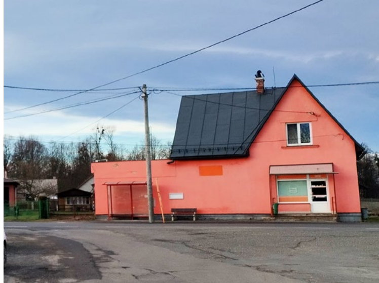
[ 4 ] Obecnie nieczynny sklep spożywczy COOP (dawniej Jednota-Jedność)
