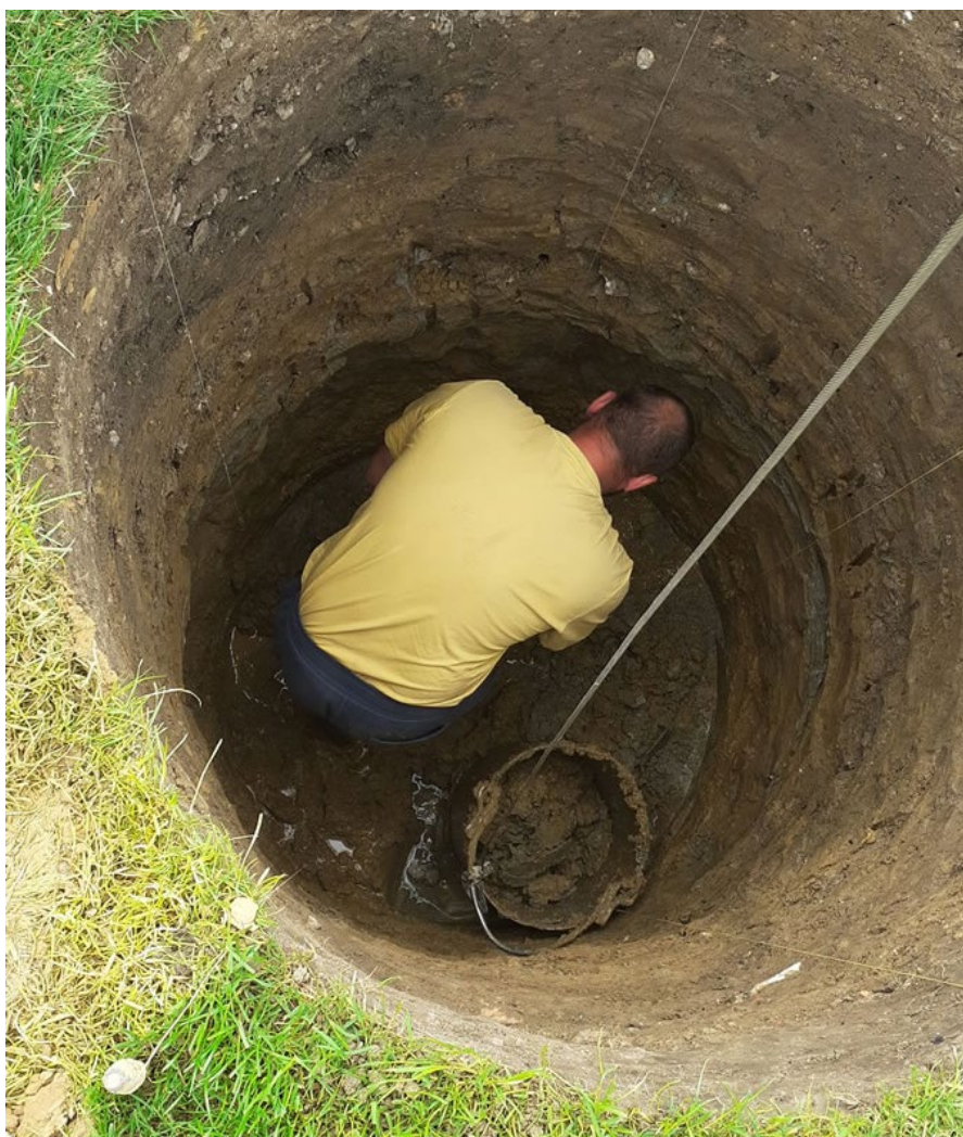
RĘCZNE KOPANIE STUDNI
