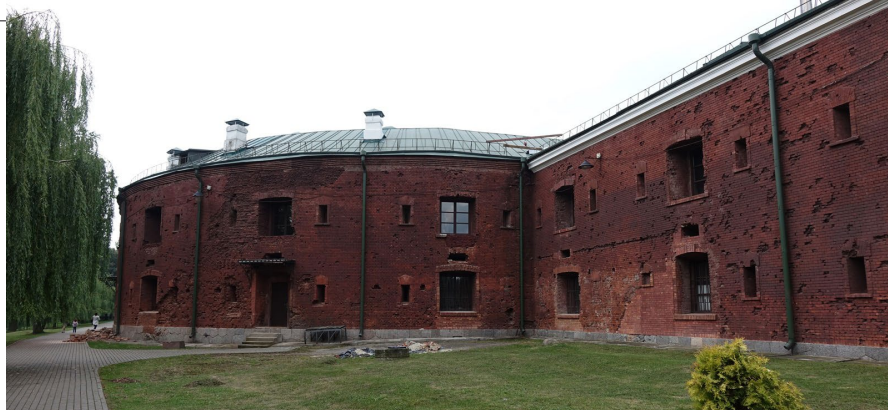
BUDYNKI BYLEJ FORTECY
