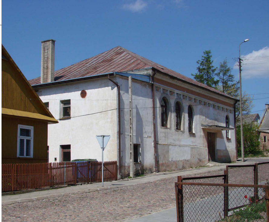
SYNAGOGA KAUKASKI BET MIDRASZ, W BUDYNKU KTÓREJ OBECNIE MIEŚCI SIĘ KINO
