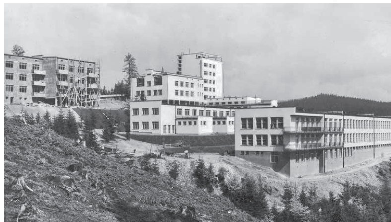
● Widok na sanatorium w budowie - lata 30. XX wieku.
