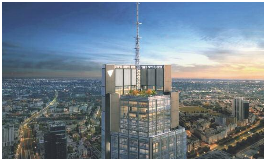
Taras widokowy w Varso Tower, najwyższym budynku w całej Unii Europejskiej, zostanie otwarty już tego lata
