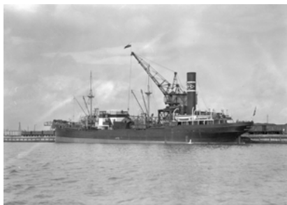
Budowa portu w Gdyni
