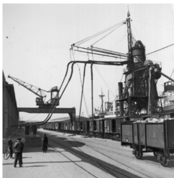
Budowa portu morskiego w Gdyni – drewniane zabudowania przy tymczasowym moło
