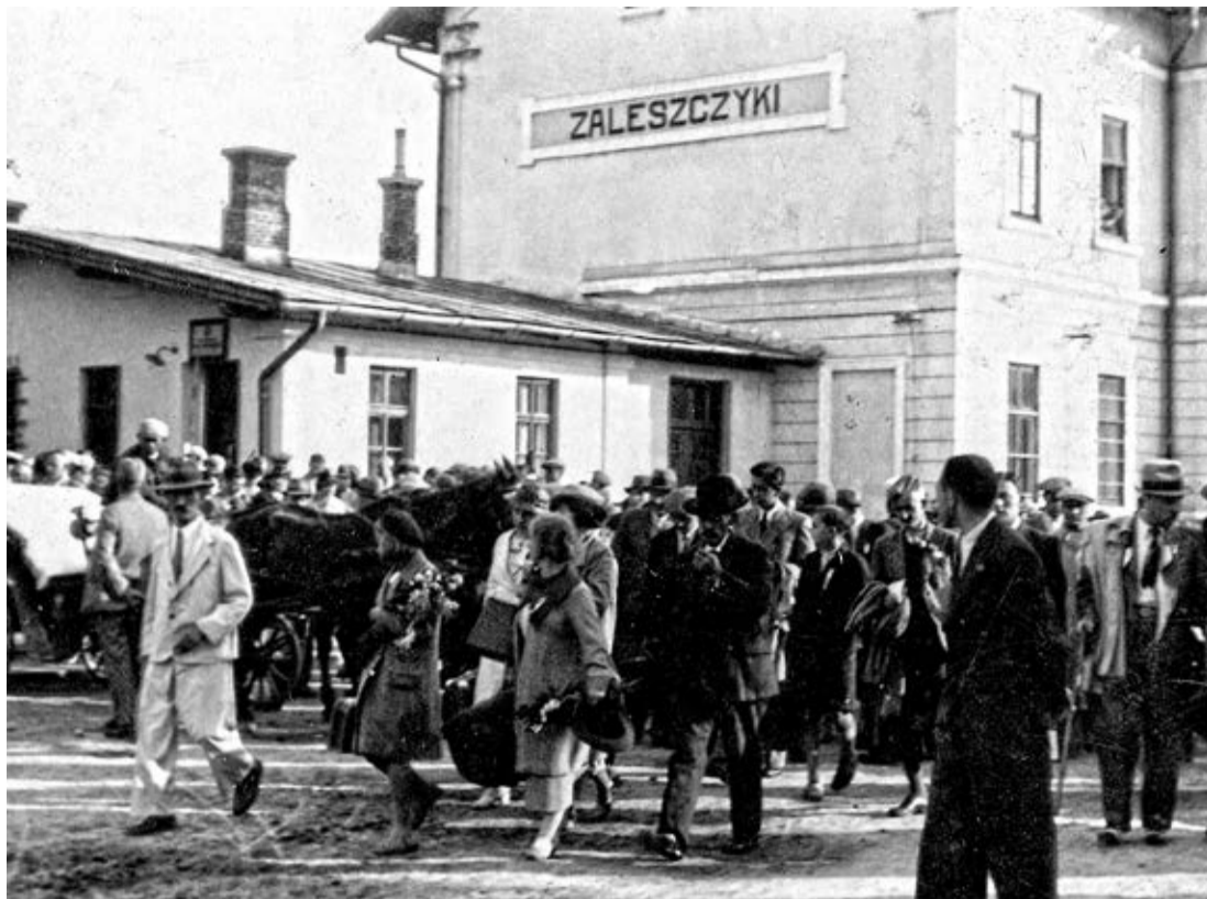
STACJA KOLEJOWA W ZALESZCZYKACH - LATA MIĘDZYWOJENNE
