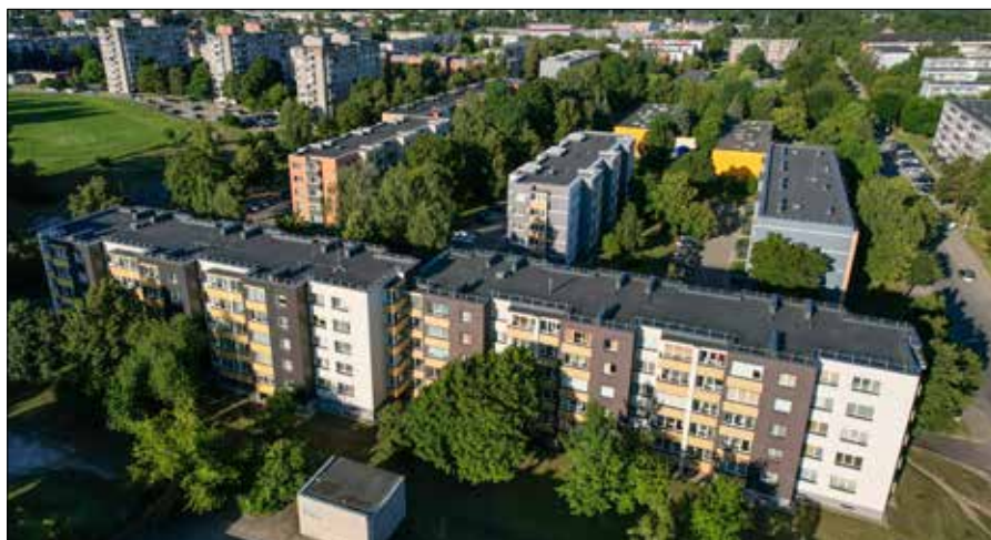
■ Odnowiony budynek mieszkalny Fot. z archiwum APVA
