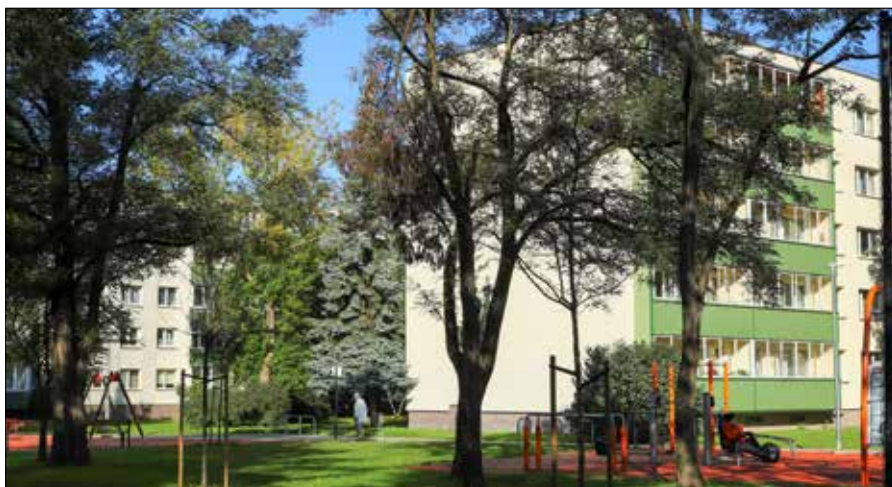
■ Odnowiony budynek mieszkalny. Fot. z archiwum APVA
