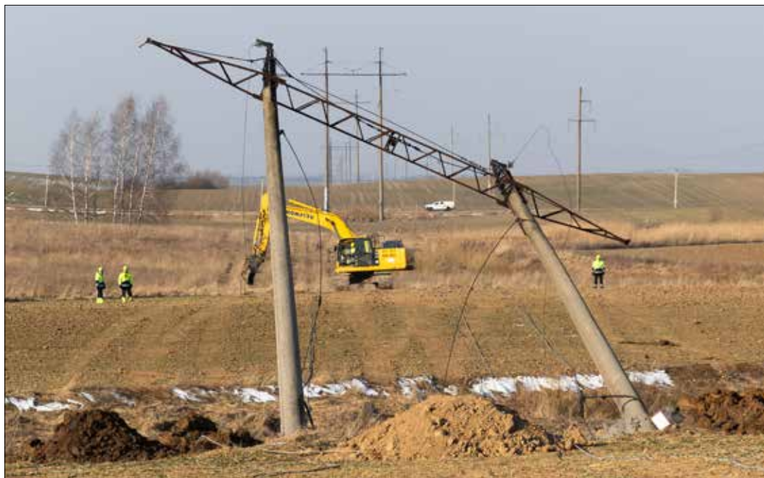
Spółka Litgrid rozpoczęła demontaż podpór linii przesyłowej Kruonis Hae–Sovetsk Fot. Dainius Labutis, ELTA
