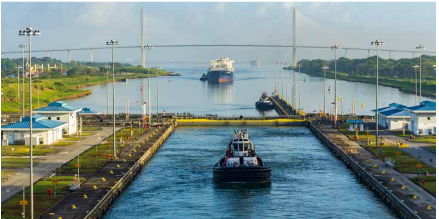
Za Kanałem Panamskim kryją się setki miliardów dolarów handlu każdego roku Fot. Adobe Stock
