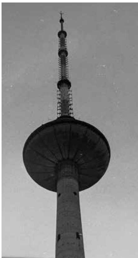
Wieża TV w Wilnie parę godzin po sowieckim ataku. 13 stycznia 1991 r.
