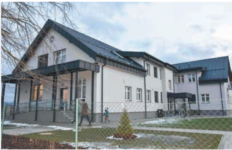
Budynek przedszkola od strony wejścia do polskiego oddziału. Fot. BEATA SCHÖNWALD
