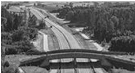
Przejście dla zwierząt nad drogą ekspresową S61
