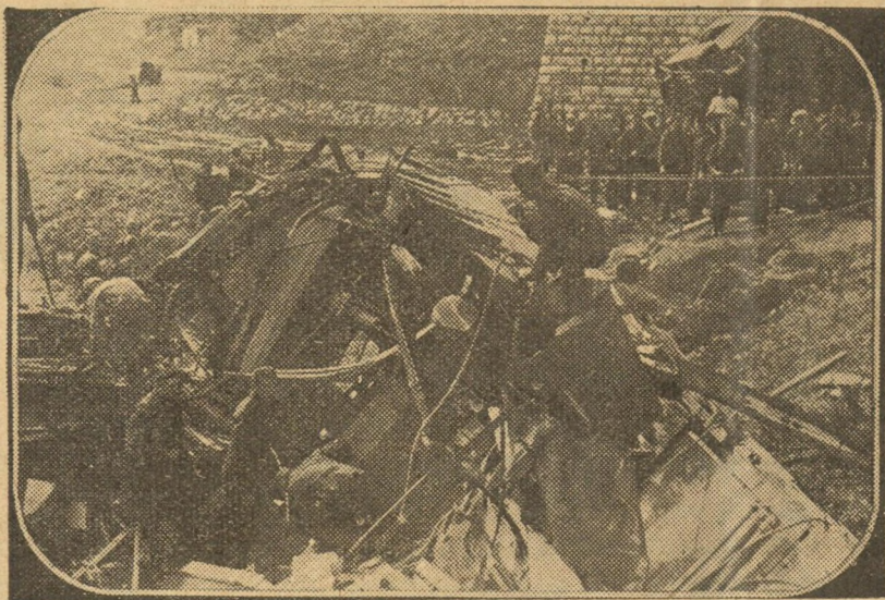
Komuniści węgierscy spowodowali wykoślenie pociągu na linii Budapeszt-Wiedeń-Kolonja, niedaleko Bia-Torbagy na Węgrzech. Katastrofa spowodowała śmierć przeszło dwudziestu osób
