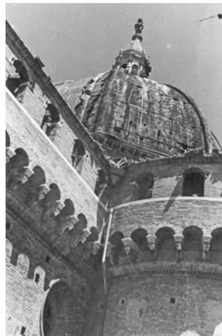
Spalona kopuła bazyliki Santa Casa di Loreto
