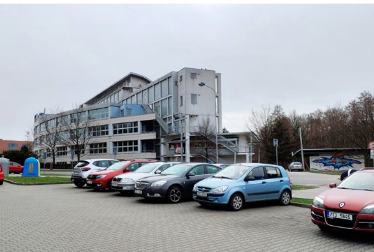
[ 7 ] Gmach czeskiego gimnazjum, który został wyróżniony za ciekawą architekturę
