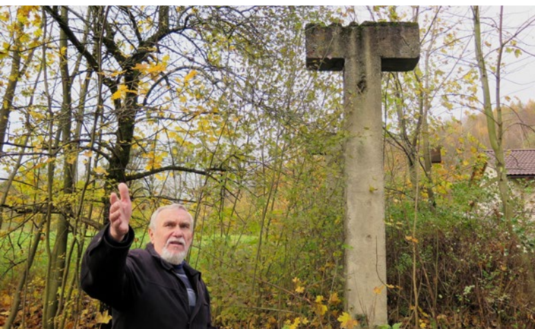
[ 43 ] Jeden z betonowych słupów będących pozostałością po rurociągu tłoczącym odpady z elektrowni przy hucie
