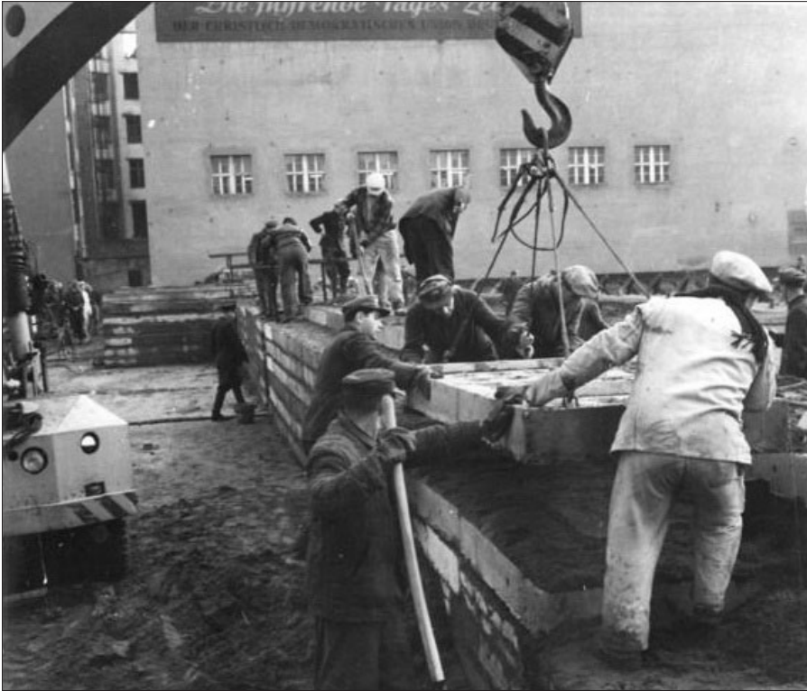
Budowa Muru Berlińskiego
