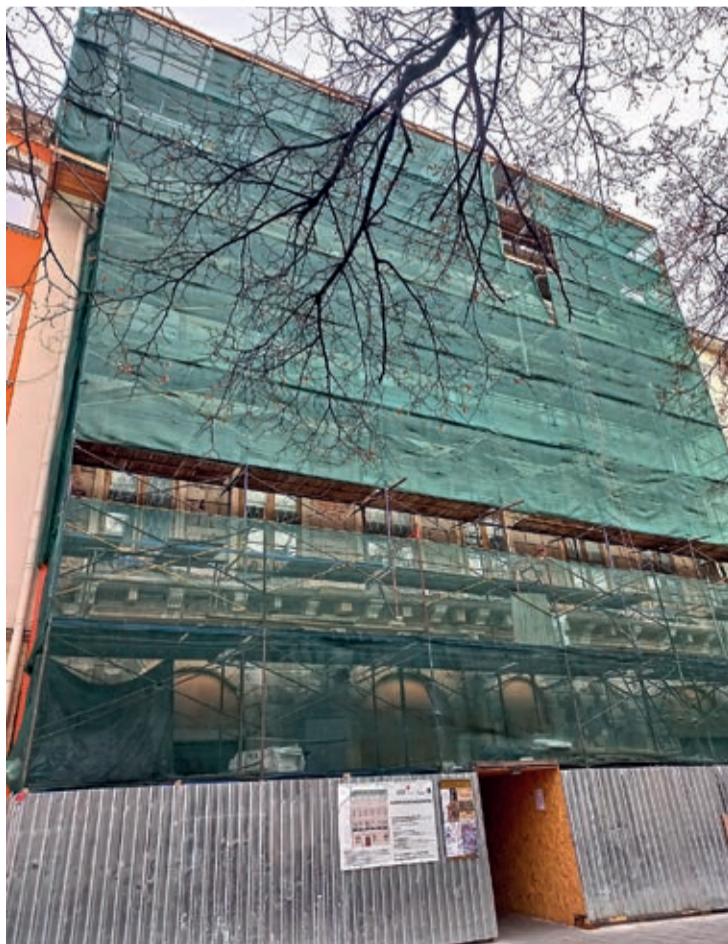
PRACE KONSERWATORSKIE PRZY FASADZIE KAMIENICY KRÓLEWSKIEJ
