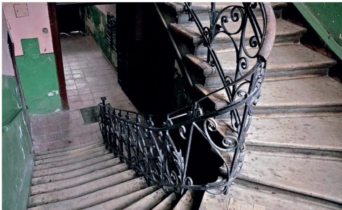
KLATKA SCHODOWA W BUDYNKU PRZY UL. ŁYŻAKOWSKIEJ 55
