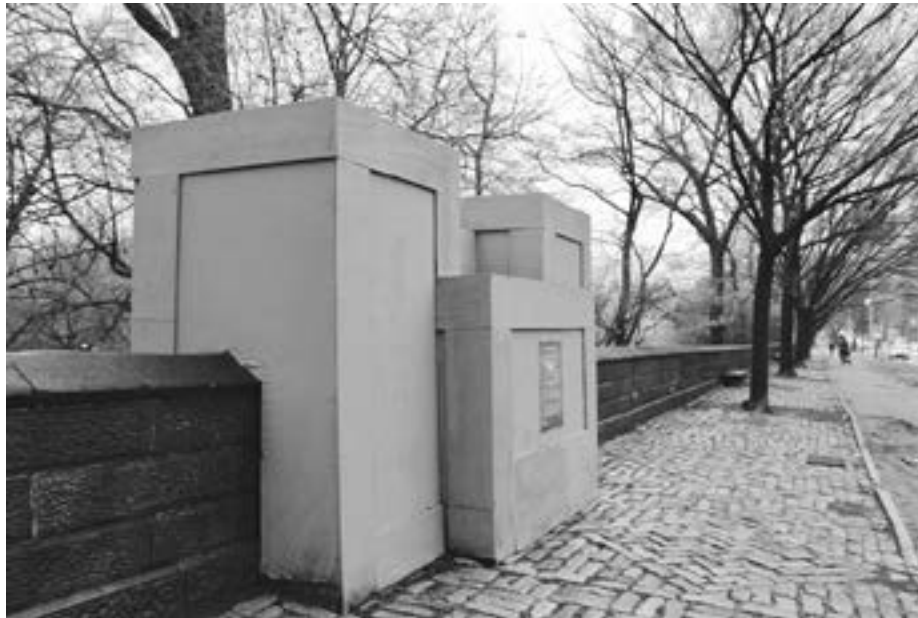
Cokół na którym stał J. Marion Sims zakryto sklejką. Jest elementem muru okalającego park, więc na razie musi zostać.
