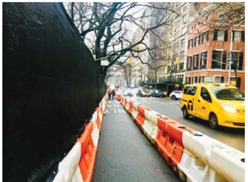
Remontowany jest również trotuar i mur otaczający Central Park
