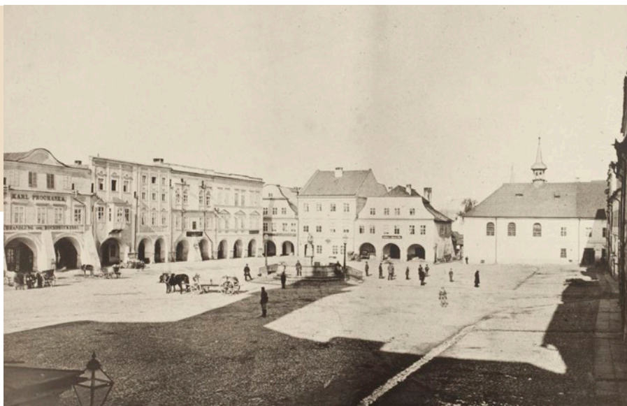
Fotografia Ryнку cieszyńskiego z 1880 r., widoczny budynek klasztoru cieszyńskich elżbietanek z charakterystyczną sygnaturką
