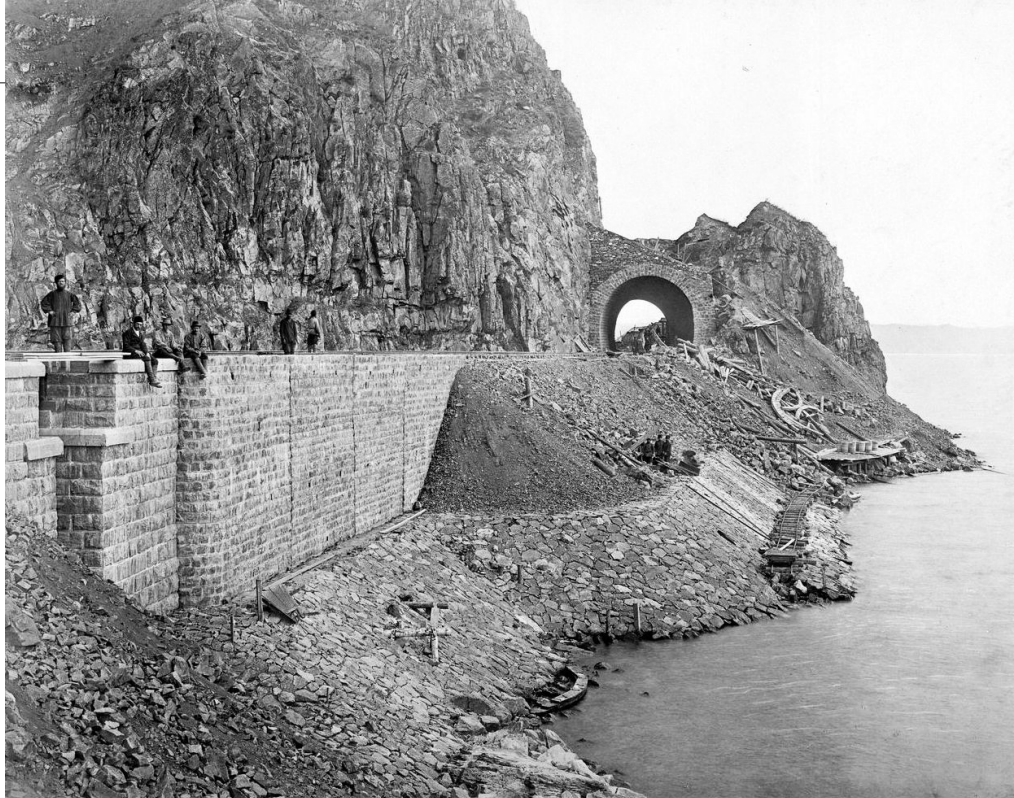
BUDOWA KRUGOBAJKALSKIEJ DRÓGI
