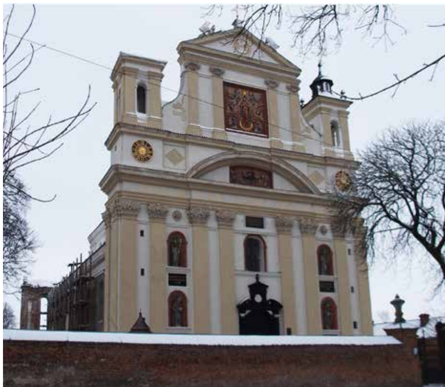
Fot. 4 Olyka (obecnie Ukraina). Fasada kościoła św. Trójcy, stan z 2022 r., fot. Fundacja Dziedzictwa Kulturowego
