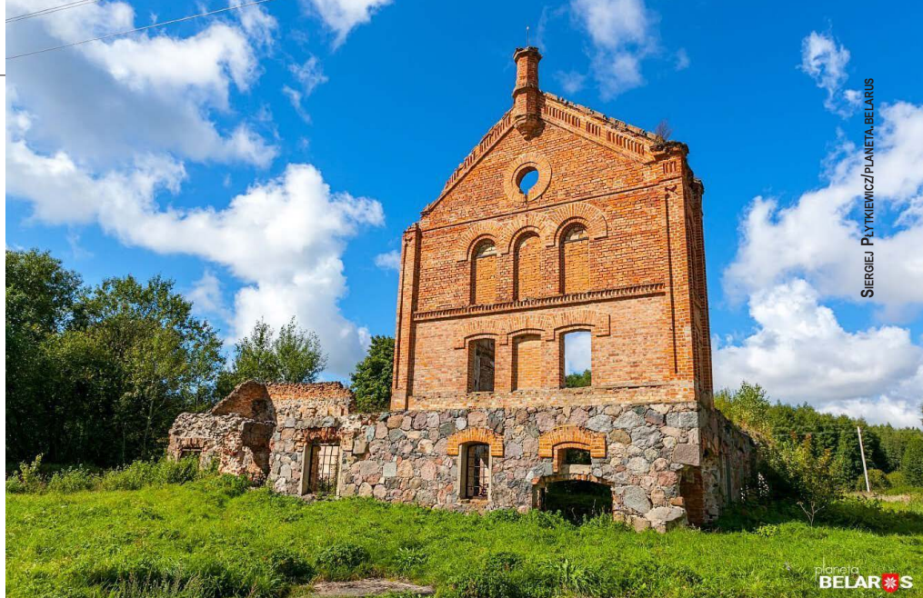
POZOSTAŁOŚCI PO SPALONYM W 1942 R. PRZEZ SOWIECKICH PATRYZANTÓW DWORZE SKIRMUNTÓW W SZEMETOWSZCZYŹNIE
