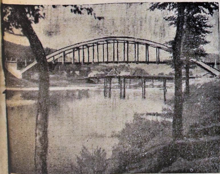
Jeden z mostów ostatnio wykończonych na Wiśle
