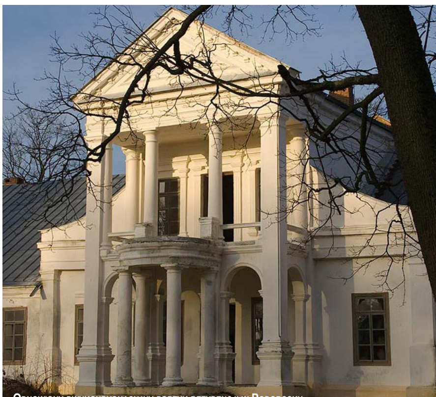
ODNOWIONY DWUKONDYGNACYJNY PORTYK REZYDENCJI W PODOROSKU
