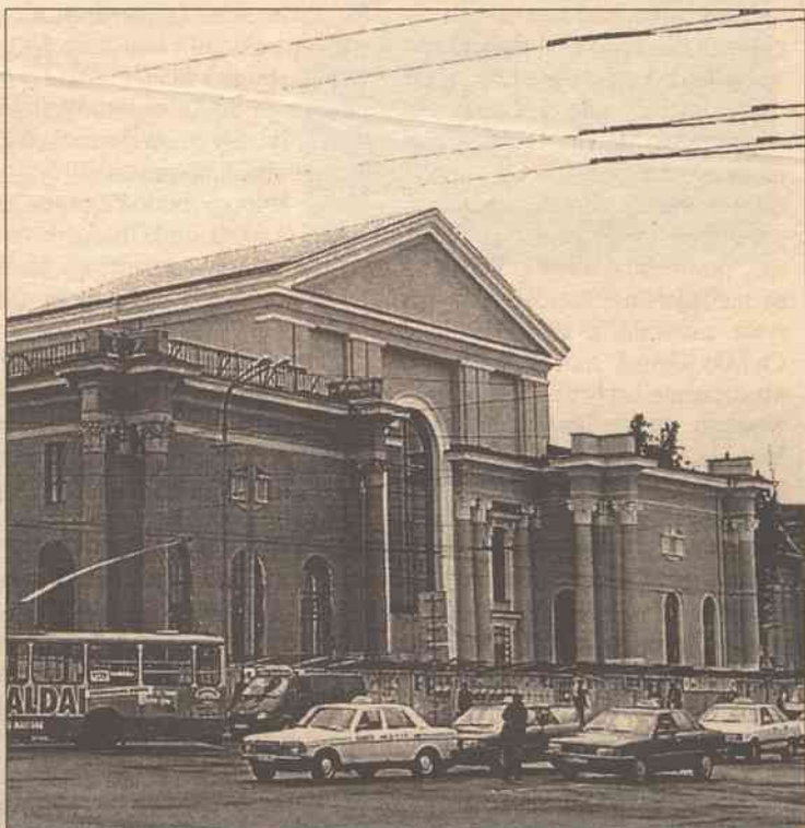
Remont na raty Dworca Wileńskiego dobiega już końca. Budowlani zabrali się do ostatniej części frontonu, przy którym jeszcze stoi żuraw budowlany. Skrzydła boczne — już wypucowane.
