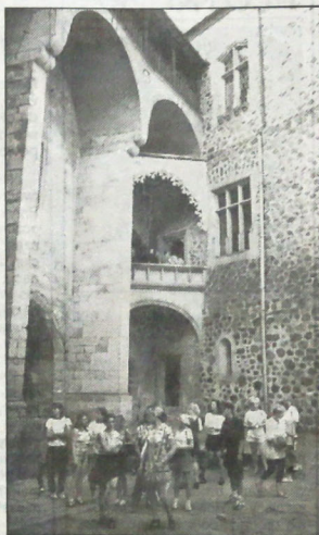
▲ Krziwoklat - balkon łączący skrzydło północne należące do królowej z apartamentami króla w skrzydle zachodnim.
