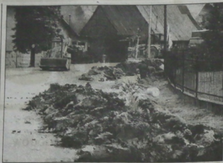
▲ Z nastaniem wiosennej pogody w wielu miejscowościach ruszyły pełną parą roboty gazyfikacyjne. Nie inaczej jest w Bystrzycy-Pasiekach (na zdjęciu). Mieszkańcy tej podgórskiej miejscowości wiążą z gazyfikacją swoich domostw duże nadzieje, przede wszystkim spodziewają się, że wraz z jej zakończeniem dojdzie do wyraźnej poprawy środowiska naturalnego. Fot. FRANCISZEK BALON
