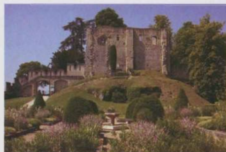
Façade principale du donjon.
