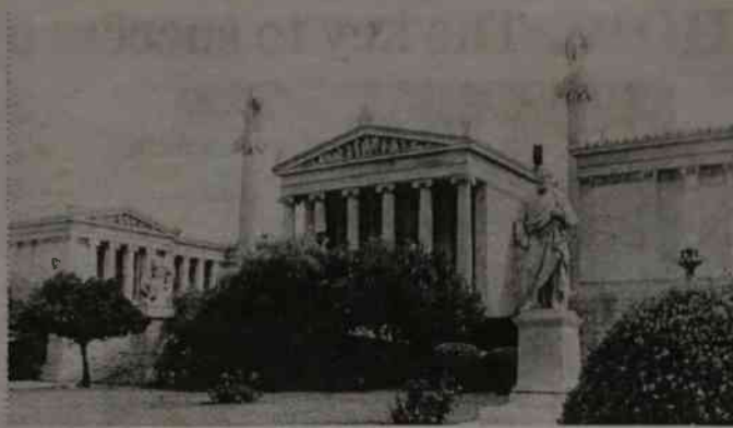
Teraz czeka nas kopanie metra pod najtrudniejszym odcinkiem ul. Panepistimiju.
