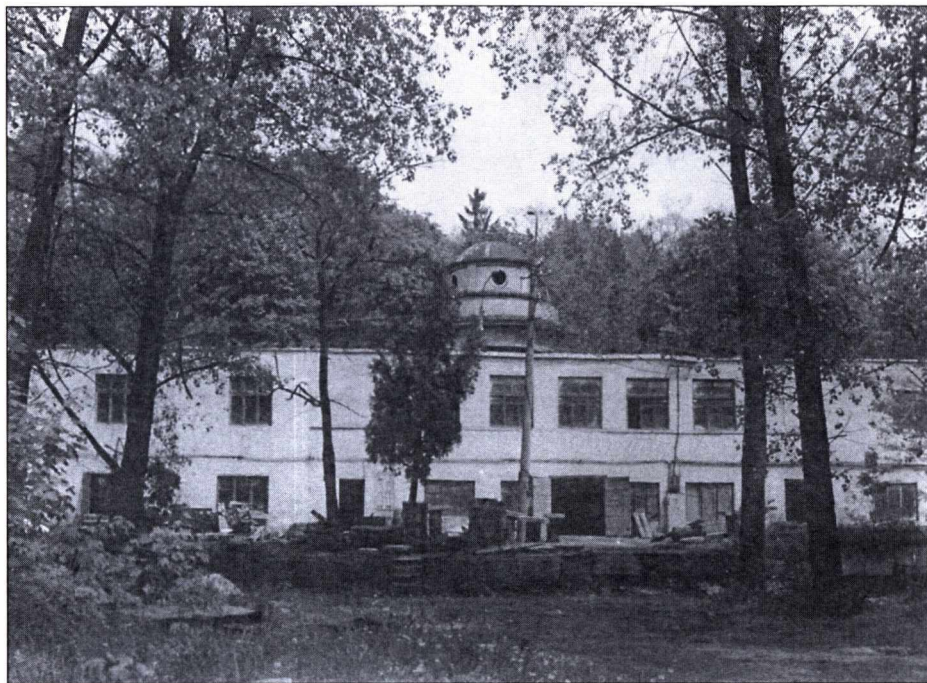
Katakumby przerobione za zakład kamieniarski
