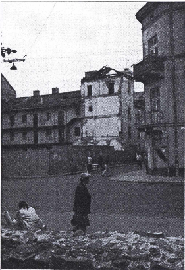
Zwalone kamienice róg ul. Wałowej i Serbskiej
