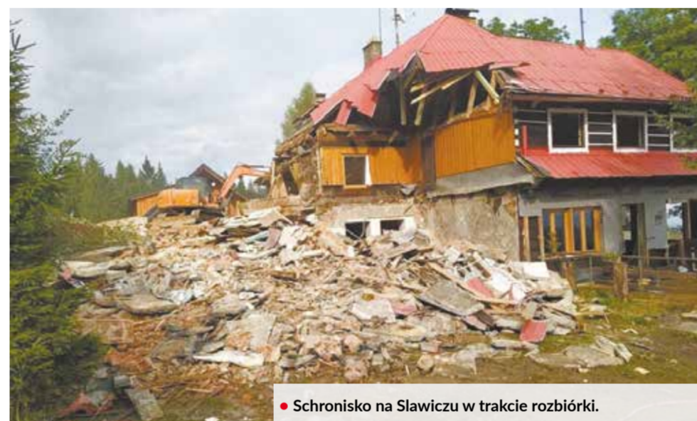
• Schronisko na Ślawnie w trakcie rozbiórki.
