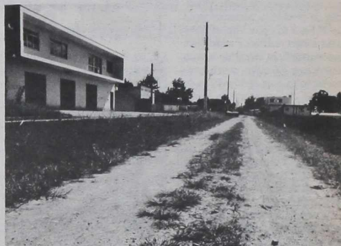
Obras de 2ª pista da Rua São Vicente de Paula.
