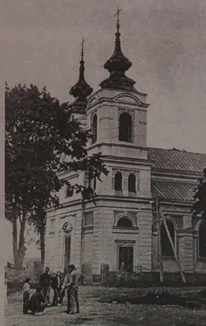
Kościół w Bieniałkonach zbudowany w 1902 roku
