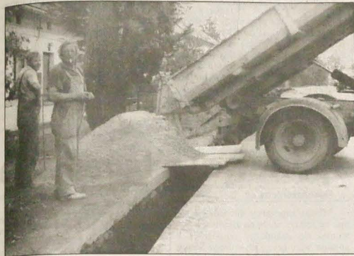
▲ Ekipa budowniczych gazociągu dotarła już pod osiedle na Górzanach. Fot. MAREK SANTARIUS
