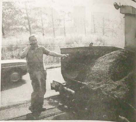
▲ Naprawę gródeckiej drogi zlecono firmie „Baltom” z Liberca. Fot. DANUTA BRANNIK
