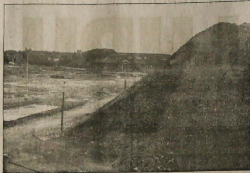
Na terenie byłej koksowni „Karolina” obecnie prace prowadzi firma „VOKD”.
