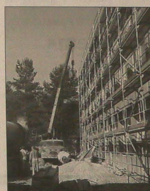
▲ Remontowany budynek szkolny w Trzynie-Tarasie otoczono rusztowaniami, trwają prace przygotowawcze na dachu, rozpoczęto też docieplanie murów zewnętrznych.
