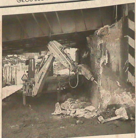
▲ Mróz oraz opady śniegu, które utrudniały w pierwszych miesiącach życia prace przy budowie drugiego pasa ruchu w trzynieckiej „misyje dzieł”, nie spowodowały jednak całkowitego wstrzymania robót. Rekonstrukcja wiaduktu, drogi i przyległych obiektów inżynierskich ma zostać zakończona jesienią br. Kosztować będzie ponad 3,8 mln euro, z czego ponad 2,5 mln pokryje Unia Europejska. Na zdjęciu: koparka z młotem pneumatycznym wgrza się w betonowy wspornik dotychczasowego wiaduktu. Fot. DANUTA BRANNA
