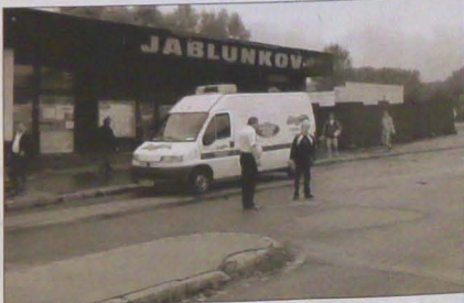
▲ Na dworcach autobusowych w Jabłonkowie latem ruszyły prace budowlane. Z boku budynku dworca wyburzono daszek, pod którym można się było schronić przed kapryśnymi pogodą, i zaczęto tu wznosić nowe mury. Jak poinformowano nas w ratuszu, nowy właściciel, miejscowy przedsiębiorca Dalibor Bulawa, zamierza w przybudówce otworzyć dwa male sklepy. Dodajmy, że właścicielem budynku była dawna spółka CSAD, która po przekształceniu się w spółkę „BUS Slesko” postanowiła sprzedać go miastu. Samorząd jednak nie był zainteresowany nabyciem budynku i trafił on w ręce prywatne. W dalszym ciągu będą się tu jednak mieścić biura spółki „BUS Slesko”, kiosk z gazetami i wyrobami tytoniowymi oraz mały bufet.
