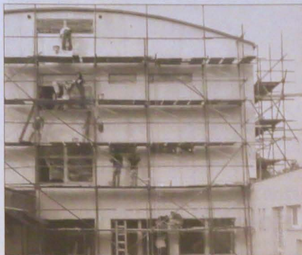
▲ Komplex szkolny przy ul. Lesnej w Jablonkowie, w którym mieści się polska i czeska szkoła, przystąpiła wreszcie w nowej szacie. W czerwcu rozpoczęli się tutaj kolejne etapy remontu - wymieniono okna, a obecnie trwa docieplenie ścian i pokrywanie ich nową elewacją. Koszty remontu obliczone na 24 mln koron pokryje miasto z dotacji państwowej. Fot. DANUTA BRANNA
