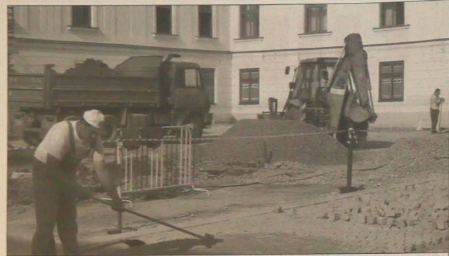
▲ Przed zamkiem w Karwinie-Frysztacie zerwano bruk, który położono tam przed kilką laty przy okazji remontu tego zabytkowego obiektu. Cały plac wyłożony zostanie od nowa płytami granitowymi, podobnie jak cały rynek, przez co ma stać się piękniejszym i bardziej bezpiecznym dla zwiedzających. Fot. BORYS SŁIWKA
