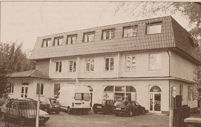
Blachodachówką firmy Qmac pokryty jest dach budynku nauki szkoły jazdy »Polák« w Cz. Cieszyńsku przy ul. Frydeckiej. Fot. z archiwum firmy
