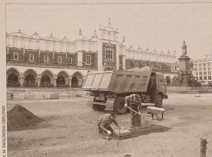
Na rozkopanym rynku trwają prace archeologiczne i budowlane.
